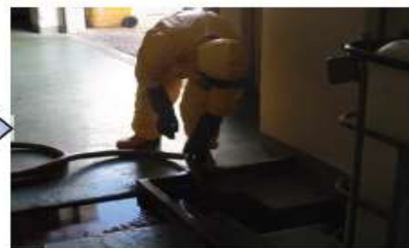
集液坑漏液處理
