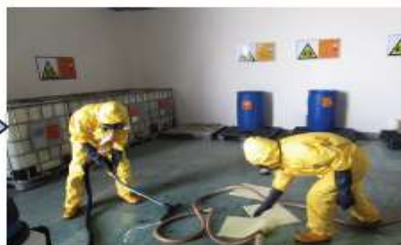
地面漏液清理
